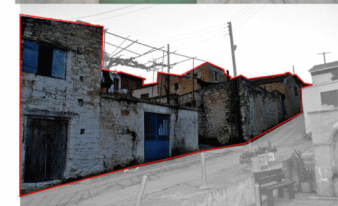
Ανομοιομορφία στα επίπεδα οροφής των κατοικιών
